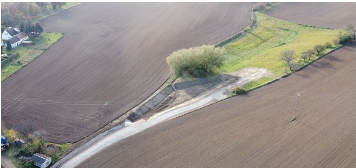
Rückhaltebecken Stockbrunnen ©TG Schrebitz
