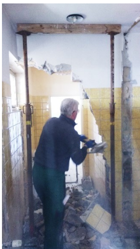
Bürgerbeteiligung an den Sanierungsarbeiten
