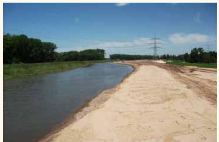
Abb. 5: Abdeckung des Baukörpers mit Mutterboden
