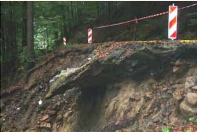
Abb. 3: Unkontrolliert abfließendes Oberflächenwasser
