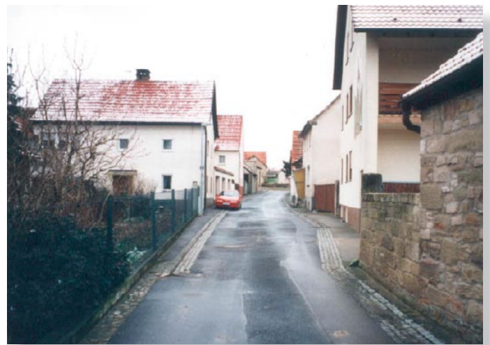
Nikolaus-Fey-Straße vor der Erneuerung
