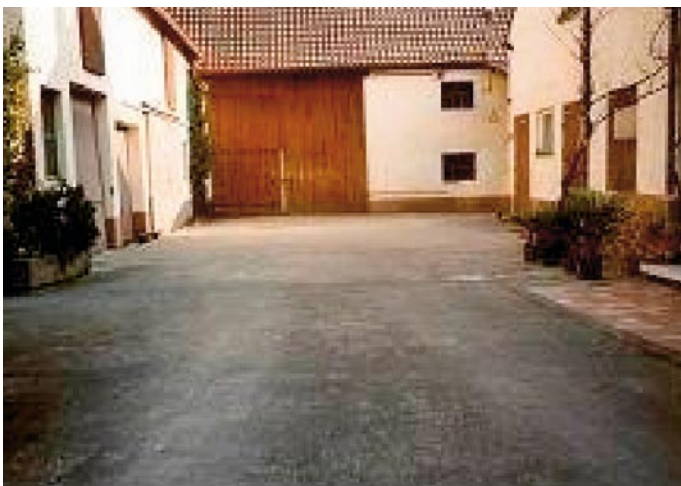
Hof der Familie Mentth vor der Erneuerung
