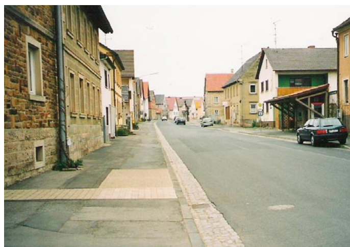
Hauptstraße vor der Erneuerung
