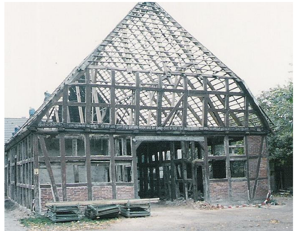
Abbau des Fachwerkhauses
