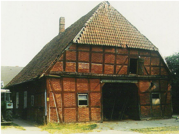
Das Vierständerrachwerkhaus von 1759 in seinem vorherigen Zustand.
