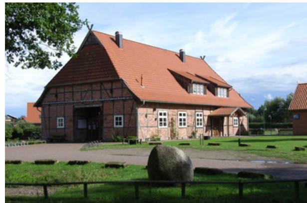
Das Vierständerrachwerkhaus heute mit Nutzung als Dorfgemeinschaftshaus.
