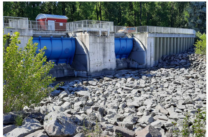
Ein- und Auslassbauwerk der HWR Meckersheim
