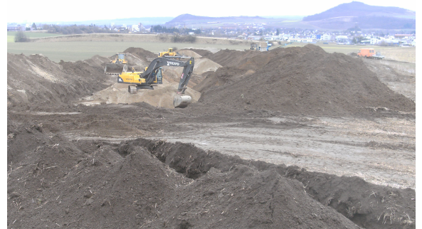
Bimsabbau bei der Unternehmensflurbereinigung Kruft [DLR Westerwald-Osteifel]
