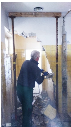
Bürgerbeteiligung an den Sanierungsarbeiten
