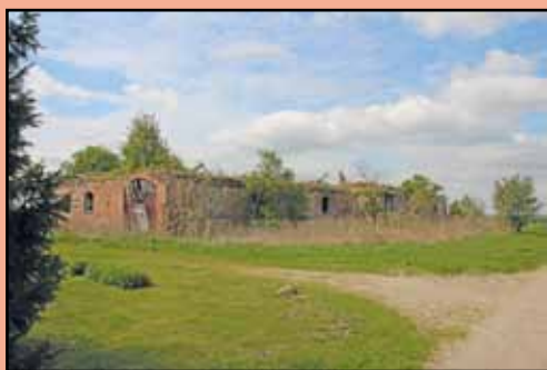
Abb. 3: Fläche mit altem Stallgebäude
