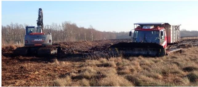
wurde den Bereichen entnommen, die wiedervernässt werden sollten. Die Entnahme erfolgt hier großräumig und flach. Um einen geregelten Abfluss der Regenwasserüberschüsse zu gewährleisten, wurden in den Verwallungen Überläufe erstellt. Handtorfstichkanten wurden zur Minderung des Wellenschlages, zur Begünstigung der Wiederansiedlung von Torfmoosen und um es dem Wild zu ermöglichen, die vernässten Bereiche ungefährdet passieren können, abgeschrägt.
