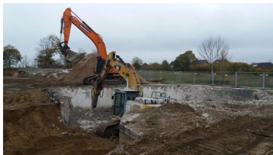
Fundamentabtragung (Foto: Backens – Amt Leezen)
