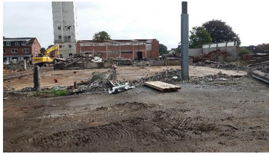
Abriss der Lagerhallen (Foto: Backens – Amt Leezen)
