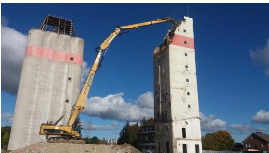
Abtragen der Silotürme (Foto: Backens – Amt Leezen)
