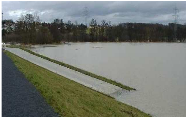
Abb. 2: Becken im Einstau I
