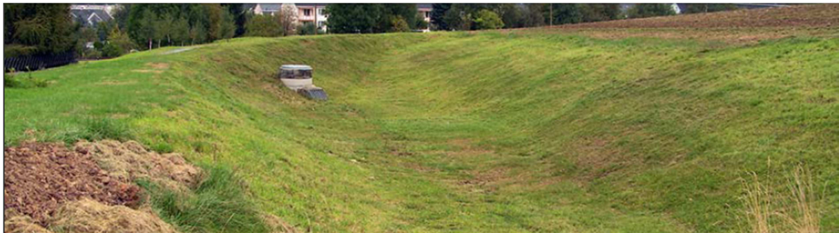
Abb. 1: Regenrückhaltebecken „Am Bahnweg“ – Blick Richtung Olbernhau
