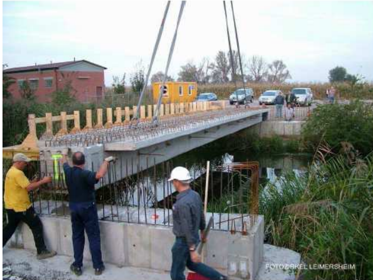
Abb. 2: Bau der Brücke über den Michelsbach
