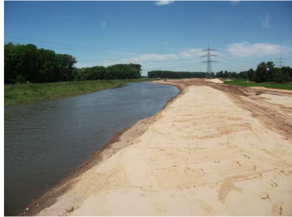
Abb. 4: Deich vor der Fertigstellung
