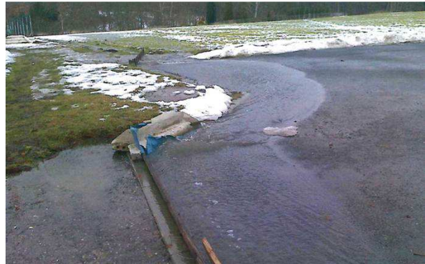
Abb. 2: Unkontrolliert abfließendes Oberflächenwasser
