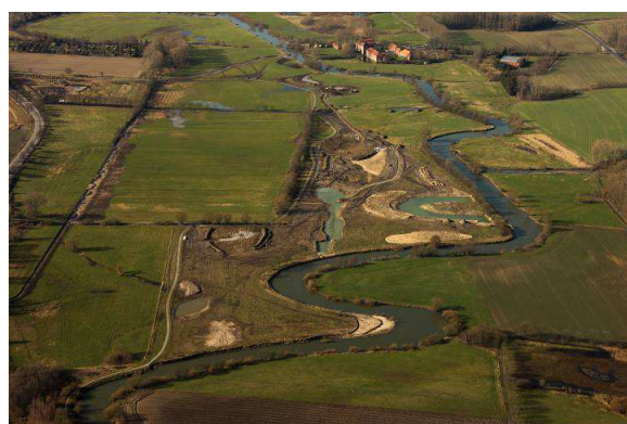
Abb. 5: Nach dem Ausbau
