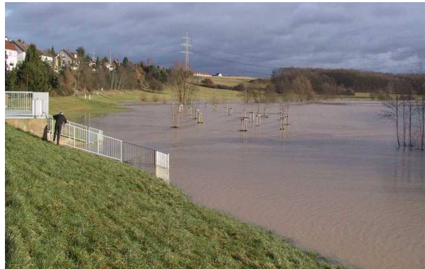
Abb. 3: Becken im Einstau II
