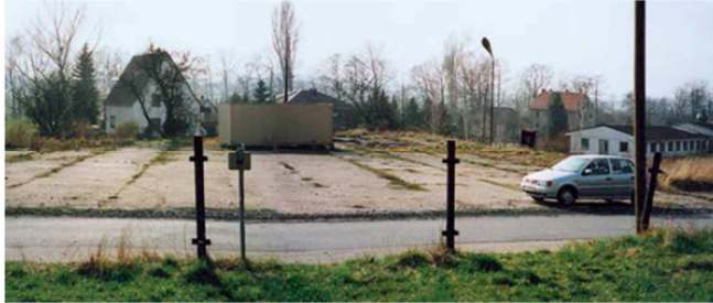
Abb. 1: Lagerfläche vor der Entsiegelung
