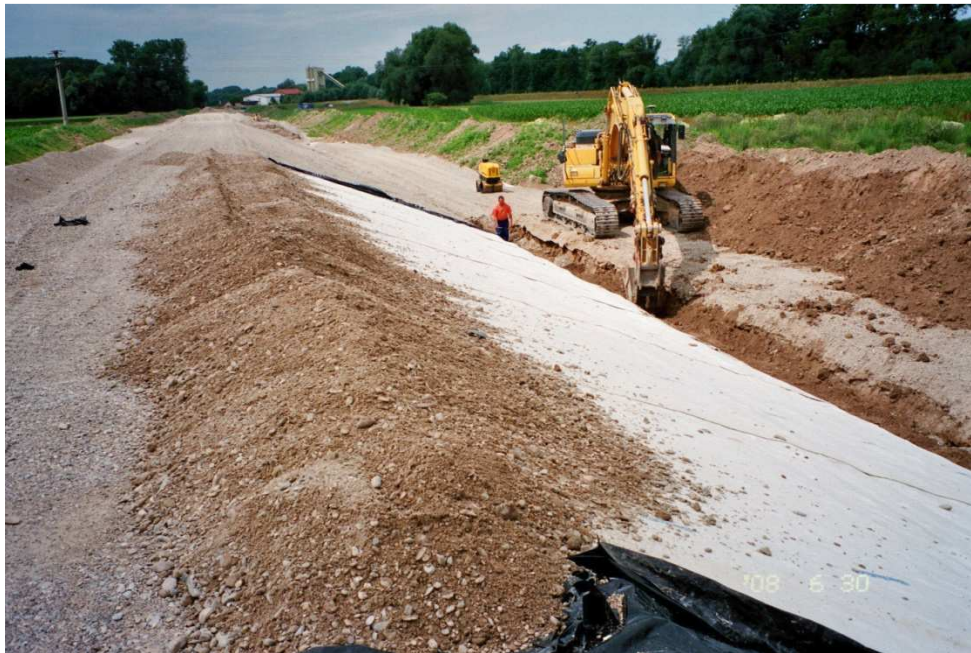
Abb. 1: Spezial-Tiefbaumaßnahmen am Deich zur Sicherung des Flutpolders Neustadt a. d. Donau.
