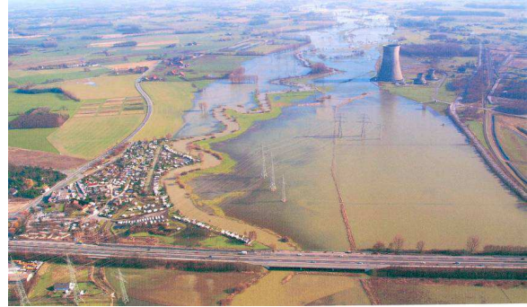
Abb. 2: Ursache und Wirkung: Lippehochwasser beim Hamm
