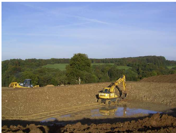
Abb. 1: Retentionsbecken im Bau
