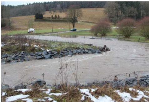
Abb. 4 und 5: Flutmulde in Betrieb
