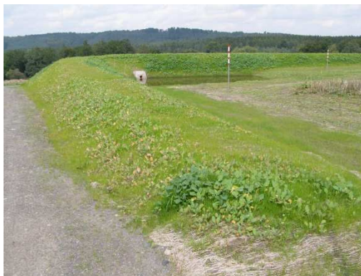
Abb. 3: Rückhaltebecken als zweiarmiges Dammbauwerk
