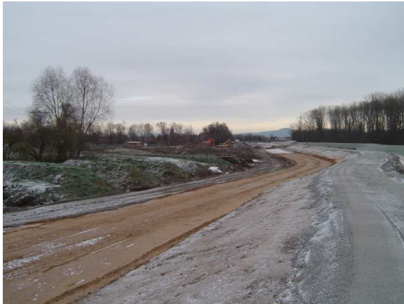
Abb. 3: Deichrückverlegung im Unterbau
