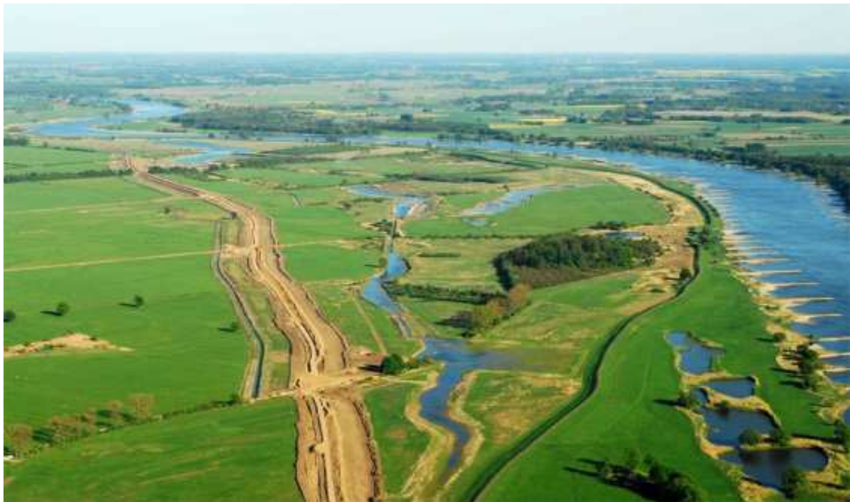
Abb. 1: Deichbaustelle links, Elbe und Altdeich rechts im Bild
