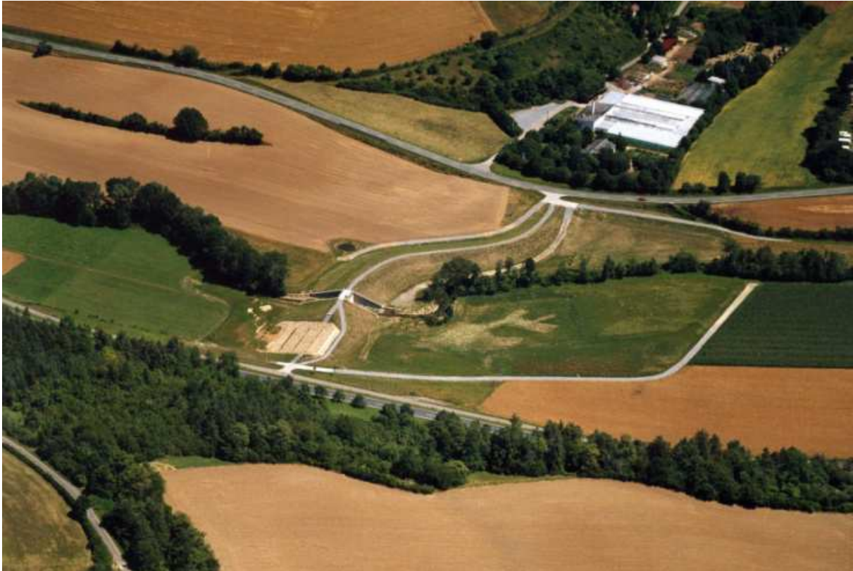
Abb. 3: Hochwasserdamm und Einstaufläche
