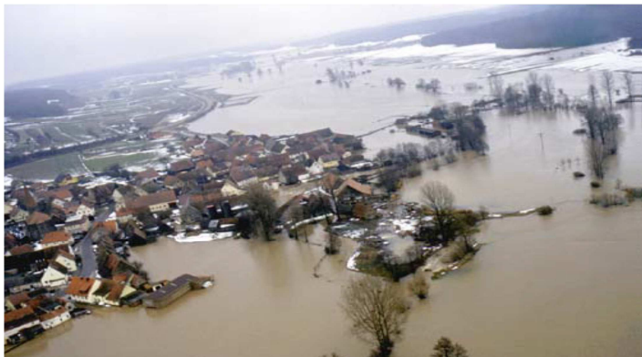
Abb. 1: Nicht nur die breite Rezataue, sondern häufig auch Ortslagen wurden vom Hochwasser heimgesucht, das dort zuweilen schwere Schäden an Haus und Hof hinterließ
