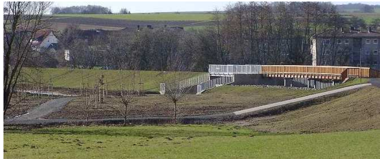
Abb. 1: Damm mit Auslaufbauwerk
