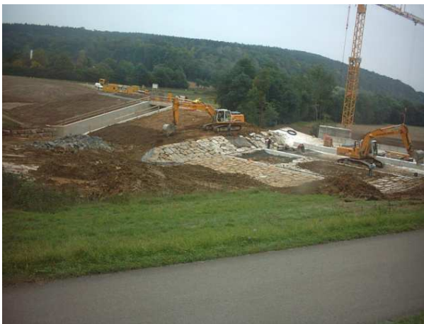
Abb. 1: Bau des Hochwasserdammes
