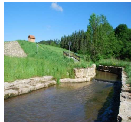
Abb. 3 Ein 100 m langer und bis zu 5 Meter hoher Damm schließt das schmale, langgezogene Silberbachtal ab.
