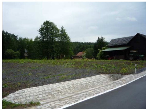
Abb. 3: Verwallung und gepflasterter Graben
