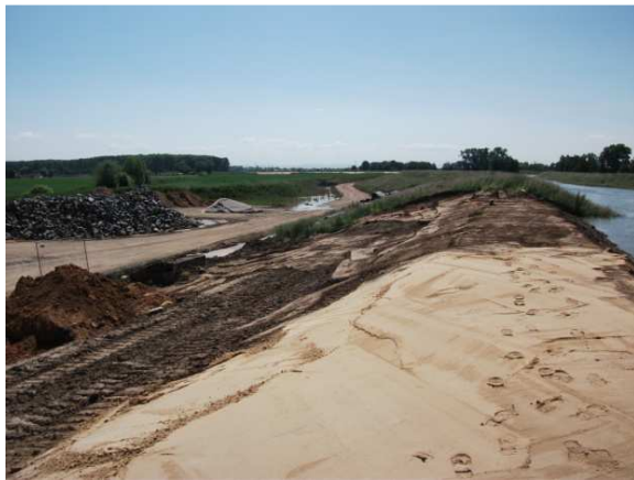
Abb. 5: Abdeckung des Baukörpers mit Mutterboden
