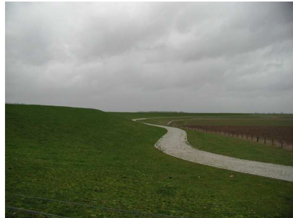
Abb. 4: Neuer Deich mit Verbindungsweg
