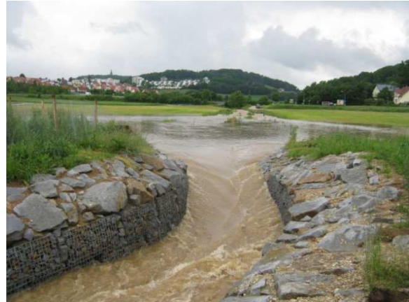
Abb. 3: Hochwasser am Krumbach im Juni 2013
