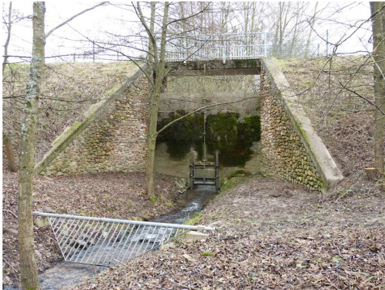
Abb. 2: Dammbauwerk mit Durchlass
