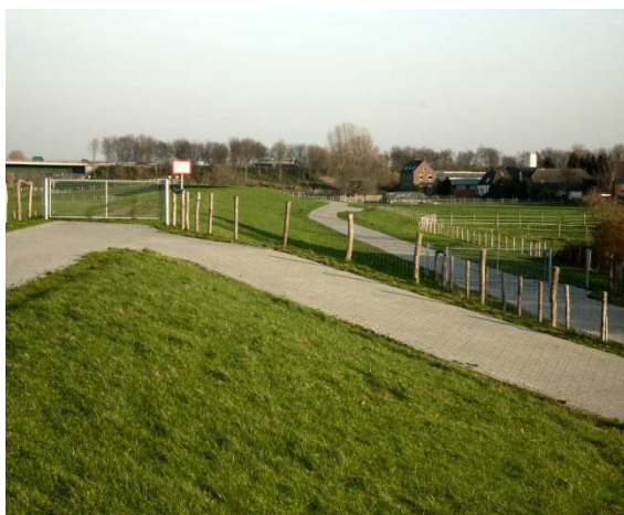
Abb. 2: Deich nach Sanierung
