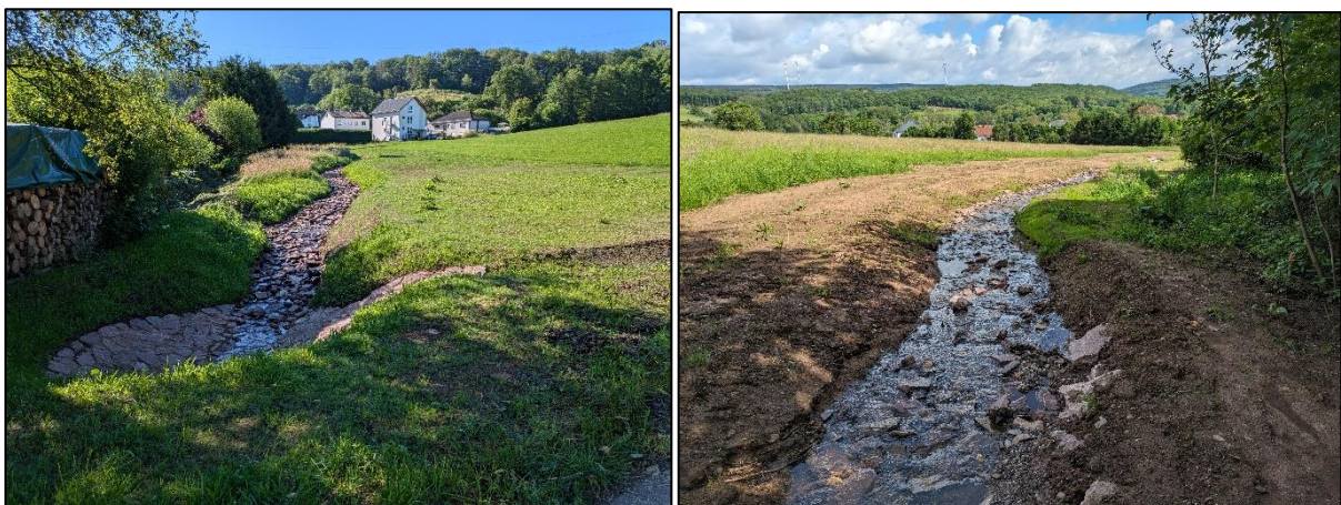
Abbildung 8 und 9: Neuer Verlauf des Wattenbruchgraben
