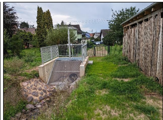
Abbildung 7: Neues Einlaufbauwerk am Haaggraben
