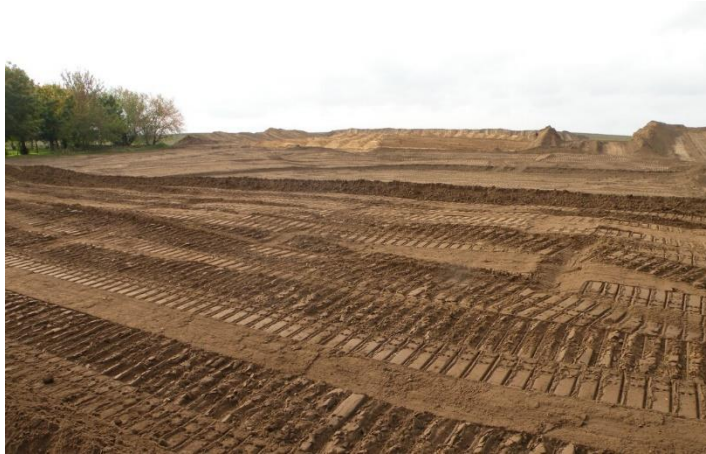
Abb. 4: Einbau der Bodenschichten. Im Vordergrund die Speichermulde, im Hintergrund der großflächige Einbau des überschüssigen Unterbodens, © TG Berbisdorf
