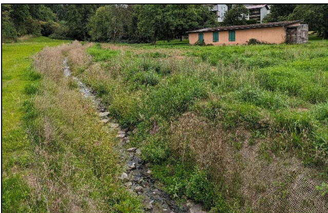
Abbildung 6: Haaggraben nach der Verlegung
