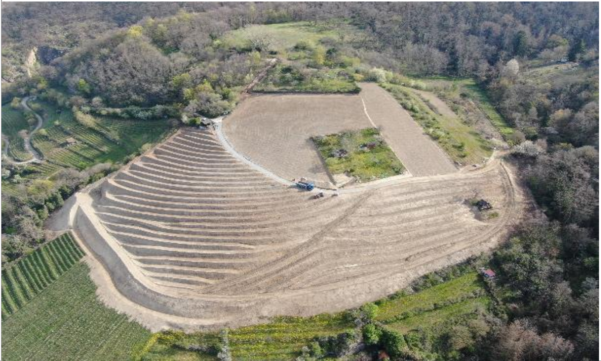
Abb. 5: Nach Fertigstellung der Weinbergsfläche) (Drohnenaufnahme Ing. Büro ISK am 04.05.2021)
