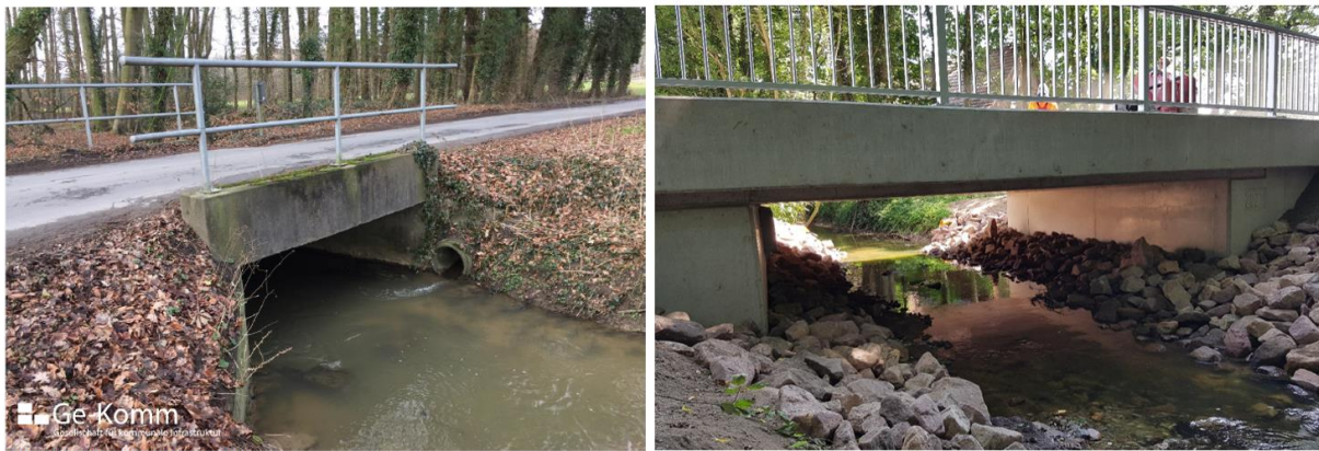
Foto: Ge-Komm GmbH – Brücke über die Hessel
