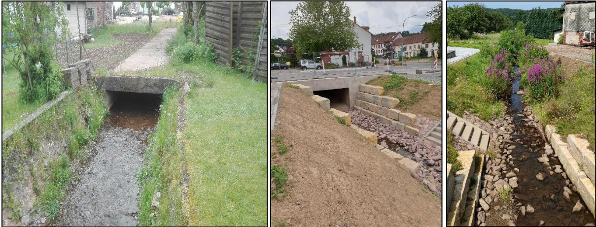
Abbildung 5 bis 5: Situation am unteren Wiesbach vor der Offenlegung (linkes Bild) und im Nachgang (rechte Abbildungen)
