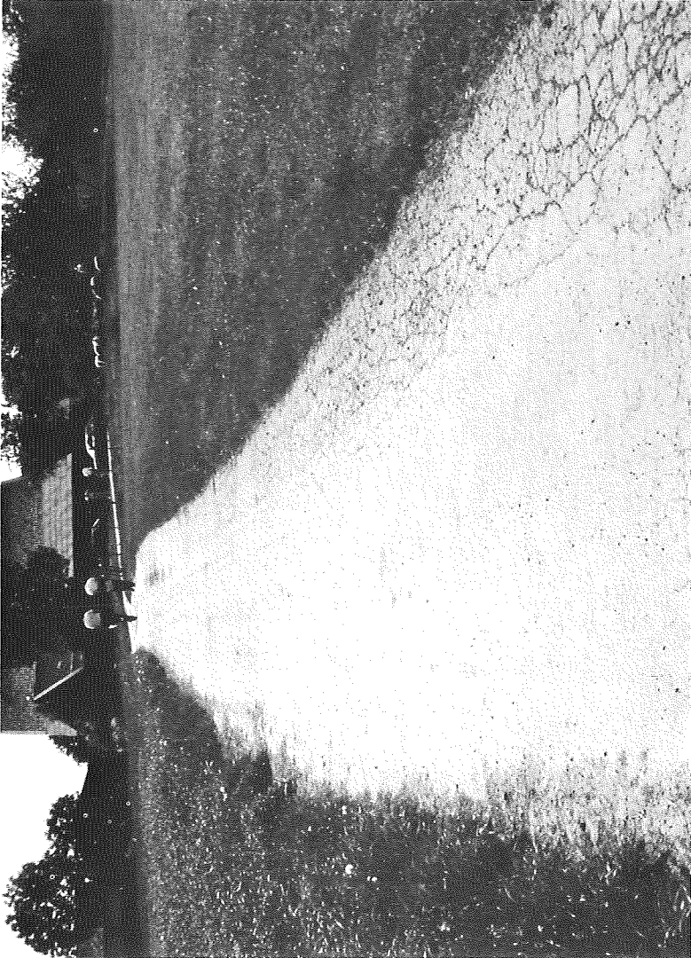
Bild 10 Sehr geringe Schicht, 120 \text{ kg/m}^2 \hat{=} 5 \text{ cm} bei 9 Jahre alter AOB-Strecke (Windpassing, Weg Nr. 73)
