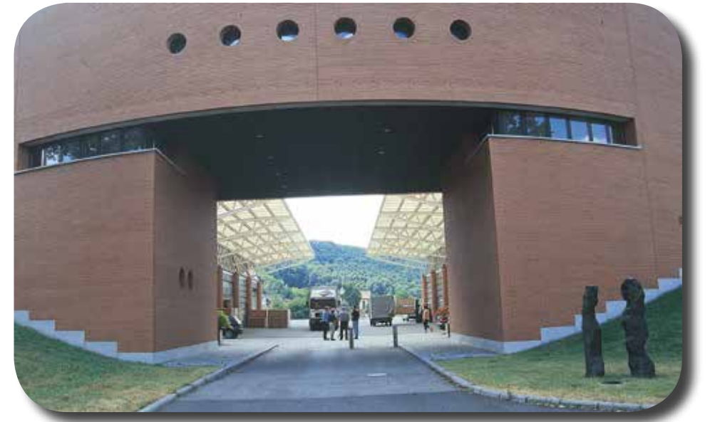
Abb. 20: Dass auch international renommierte Firmen vom ländlichen Raum aus erfolgreich agieren können, zeigt die Fa. Benkert in Altershausen, Lkr. Haßberge (Hersteller umweltfreundlicher Freilandmöbel). Sie trägt nebenbei auch maßgeblich zur Auslastung der örtlichen Hackschnitzelheizanlage bei. Den Impuls für die Verlagerung der Firma von Schweinfurt nach Altershausen gab die Initiative der ökologisch ausgerichteten Dorferneuerung Altershausen.
