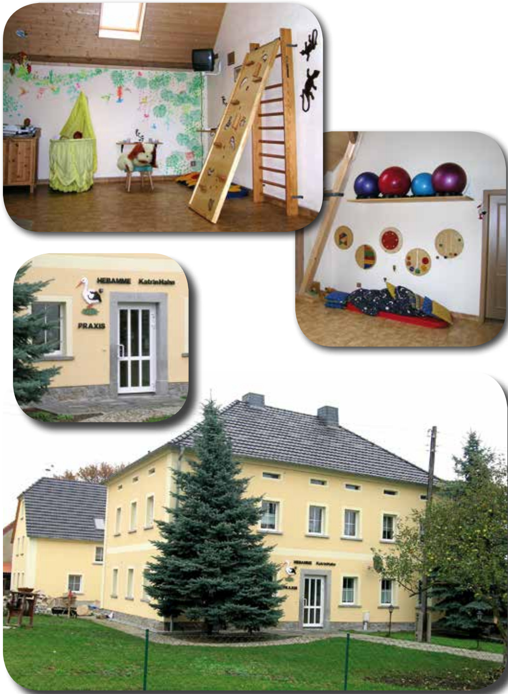
Abb. 11: In Pließkowitz (Sachsen) wurde eine Hebammenpraxis und Ergotherapie auf behutsame Weise in die ländliche Baussubstanz integriert. Durch die Sanierung und Umgestaltung des Nebengebäudes konnte die Struktur eines Dreiseithofes erhalten werden.
