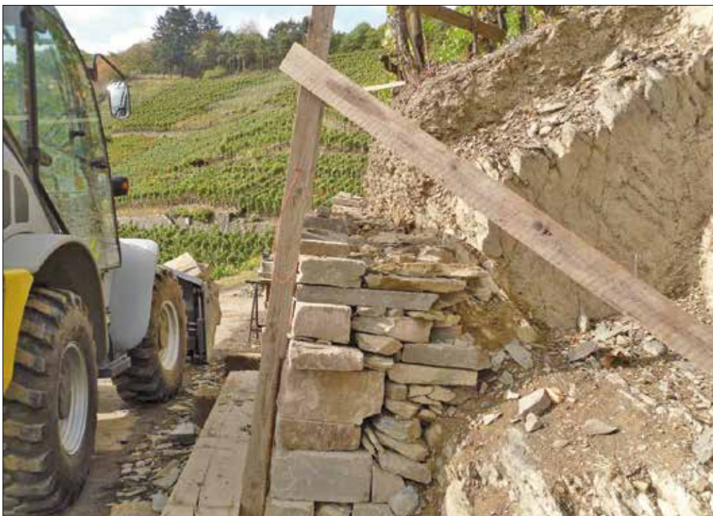
Abb. 2: Trockenmauerbau, Quelle: DLR WWOE
