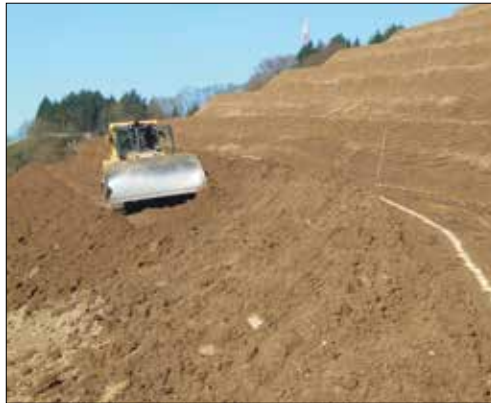
Abb.2: Einebnen der Plattform mit der Planier- raupe
