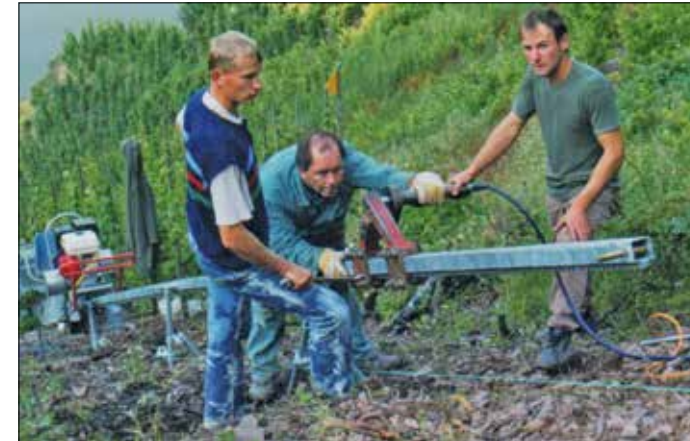
Abb. 6: Der Schienenstrang wird im Calmont dem Terrain angepasst gebogen (Quelle: Rolf Goergen)
