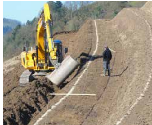
Abb.3: Abziehen der Böschung mit dem Bagger
