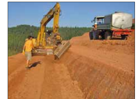
Abb. 6 : Bau von Weinbergsterrassen mit VTG-Baubetrieb
