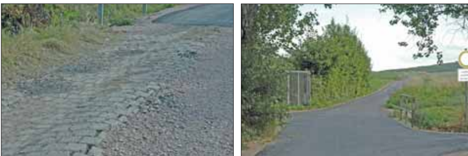
Abbildung 14: Asphaltweg, Region Mainz/Bingen
