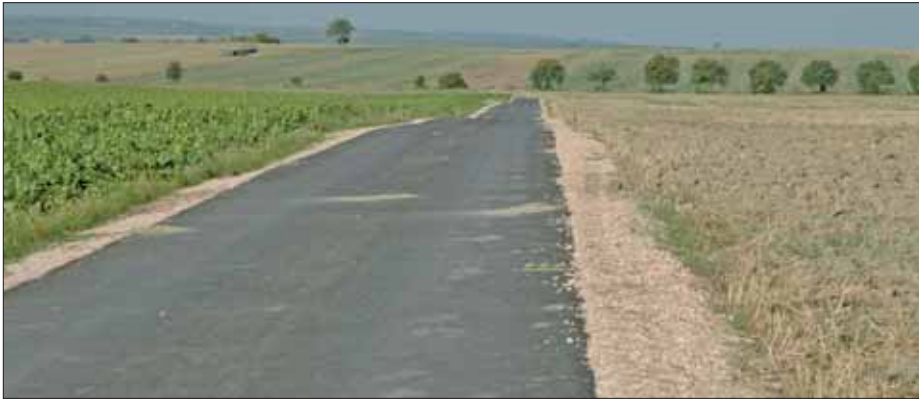
Abbildung 13: Asphaltweg, Region Mainz/Bingen
