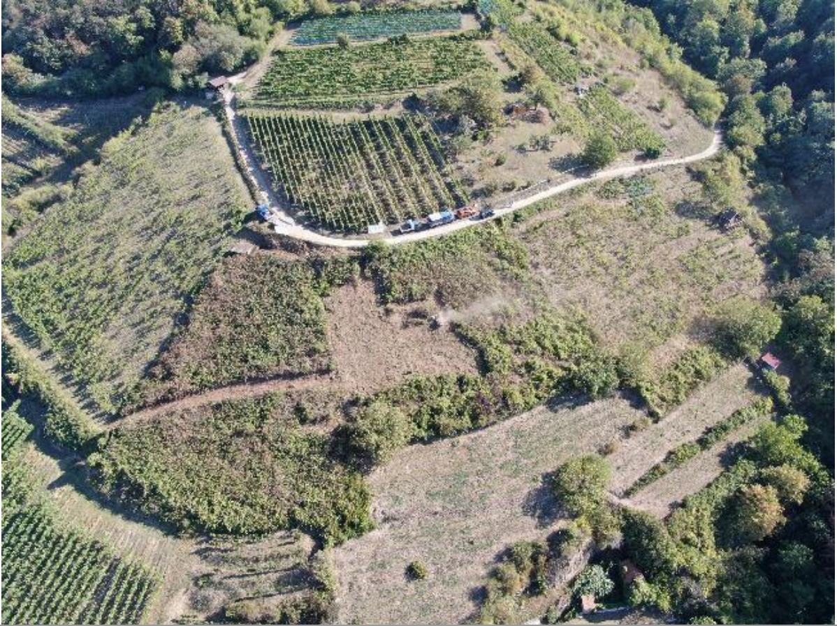
Abb.3: Rodungsarbeiten im Rahmen des Flurbereinungsverfahrens am 11.09.2020. Den Weinbergen ist der Trockenstress anzusehen. Die Reihen sind sehr lückenhaft. Ohne Bewässerung würden diese Flächen nicht mehr neu angelegt werden. (Foto Ing. Büro ISK)
