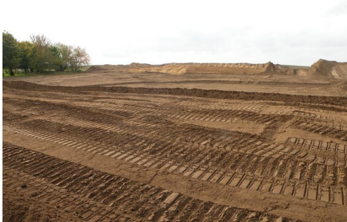
Abb. 4: Einbau der Bodenschichten. Im Vordergrund die Speichermulde, im Hintergrund der großflächige Einbau des überschüssigen Unterbodens, © TG Berbisdorf
